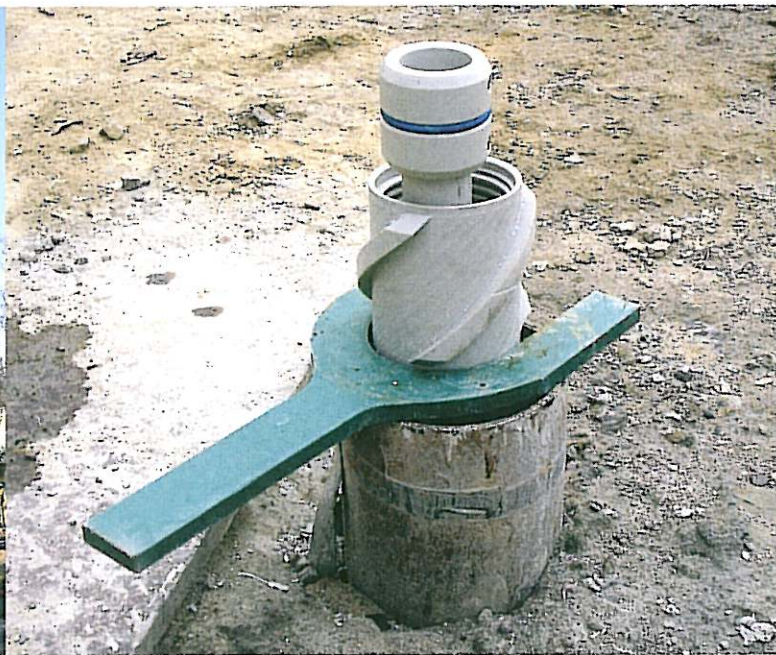
Då hålen färdigstälts installerades en speciell borrhålsvärmväxlare i vart och ett av hålen, levererad av Pemtec. Växlaren har ett isolerat centrumrör och öppen hålvägg. Installationen krävde utveckling av nya hjälpmedel och rutiner.
